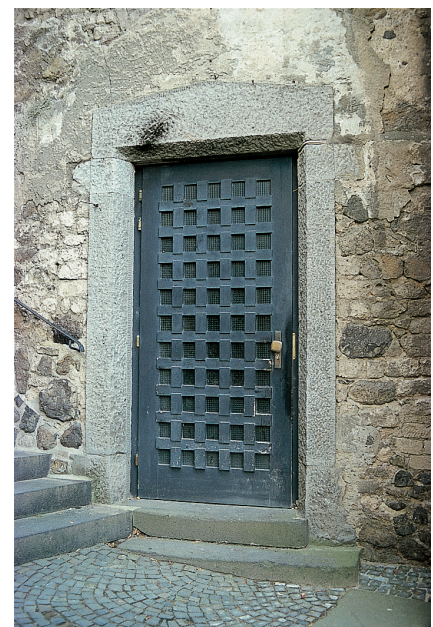
Abb. 7. Zugang zum Kellergeschoss des Hotels (Foto: Verf.).
