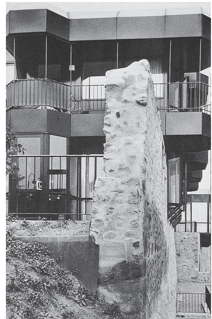
Abb. 19. Bad Kreuznach, Kauzenburg, Teilansicht von Osten (in: Deutsche Bauzeitschrift 22, 1974, Nr. 9, S. 1525).
