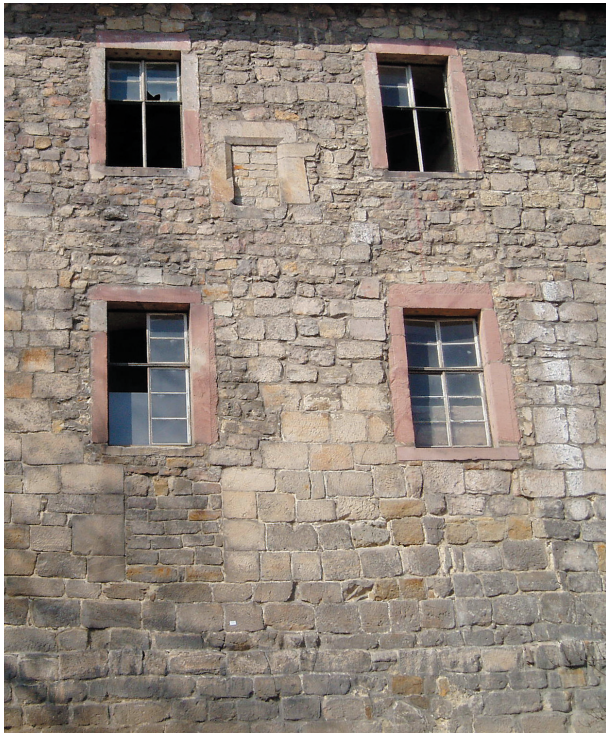
Abb. 2. Schloss Blankenhain, Ostflügel (Saalbereich). Über dem Sockel romanisches Quadermauerwerk der Ringmauer mit späteren Umbauten, Fenster von 1690, unten zugesetzte Öffnung (? Abort), oben rechts gefastes gotisches Fenstergewände, darüber ehem. gotischer Mauerabschluss (Foto: Verf.).
