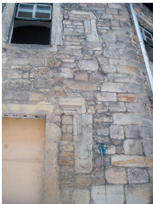
Abb. 4. Schloss Blankenhain, Nordflügel westlich des Tores. Fenster von 1690 mit Resten profiliertter Fenstergewände von ca. 1550, an der rechten Bildseite romanisches Mauerwerk (Foto: Verf., 2004).
