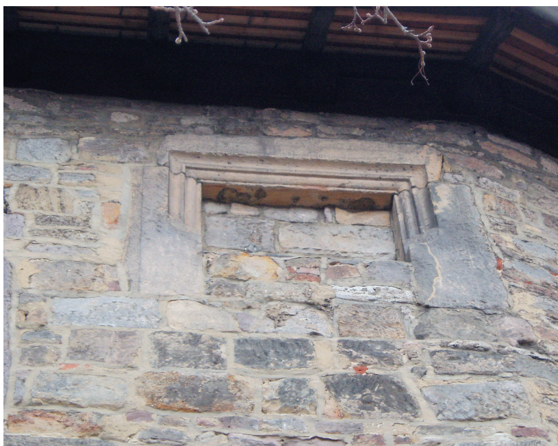
Abb. 4. Schloss Blankenhain, Nordflügel westlich des Tores. Fenster von 1690 mit Resten profiliertter Fenstergewände von ca. 1550, an der rechten Bildseite romanisches Mauerwerk (Foto: Verf., 2004).
