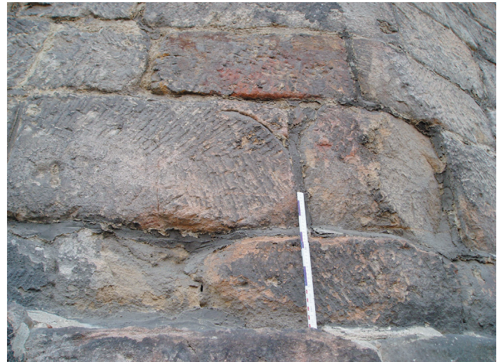
Abb. 2. Schloss Blankenhain, Ostflügel (Saalbereich). Über dem Sockel romanisches Quadermauerwerk der Ringmauer mit späteren Umbauten, Fenster von 1690, unten zugesetzte Öffnung (? Abort), oben rechts gefastes gotisches Fenstergewände, darüber ehem. gotischer Mauerabschluss (Foto: Verf.).
