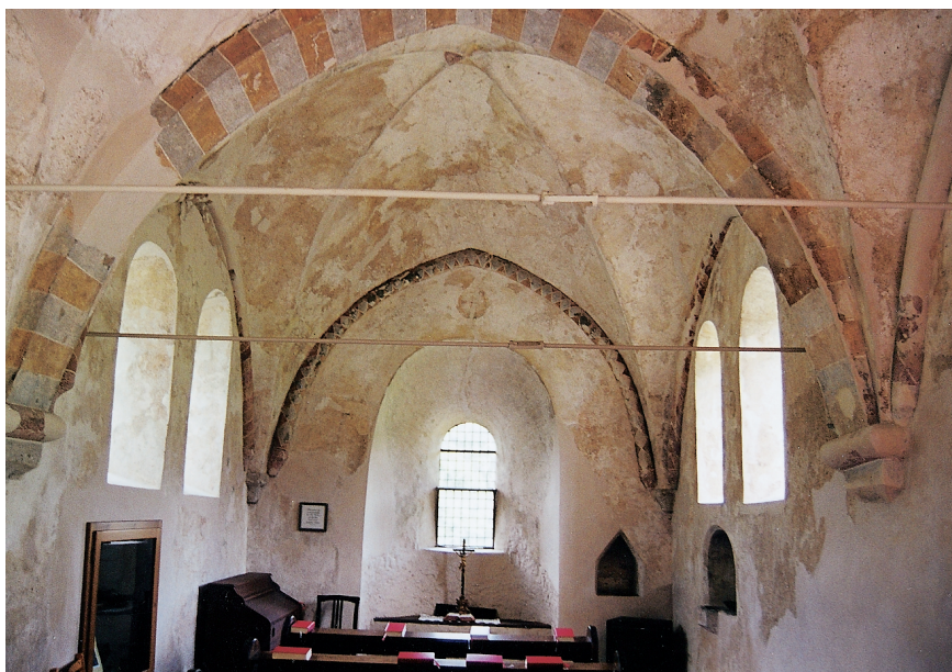
Abb. 2. Innenraum der Kapelle nach Osten (Foto: Verf. 2001).
