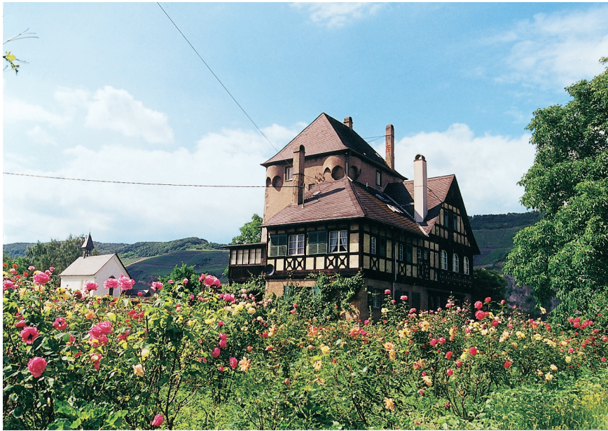
Abb. 9. Anbau von 1919/1920 von Südosten (Foto: Verf., 2001).
