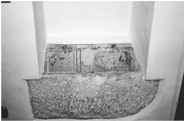
Abb. 7. Regensburg, Löblturm, steinerner „Tresor“ (Foto: Verf.).
