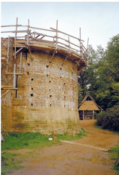
Abb. 9. Der Bergfried zeigt zwei Formen der auf Guédélon angewandten Mauerwerksstrukturen: Das Fundament besteht aus dem (kostspieligeren) Quadermauerwerk (*appareil régulier*), die darüberliegenden Lagen sind mit dem unregelmäßigen Bruchsteinmauerwerk (*appareil irrégulier*) errichtet worden. Die vier Reihen eingeschobener Quader sind ein Dekorationselement (und markieren gleichzeitig die Lage des Geschossbodens) (Foto: Verf.).
