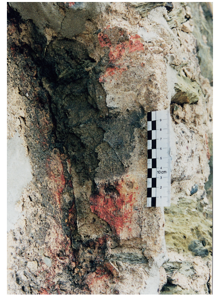
Abb. 10. Blendbogenlaibung am Pulverturm mit Putz- und Fassungsresten, insb. Fugenstrich (Foto: F. Lawen).
