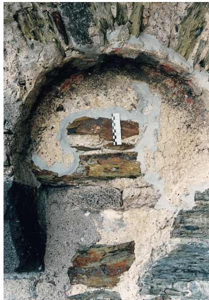
Abb. 8. Blendbogen am Pulverturm mit Putz- und Farbfassungsresten (Foto: F. Lawen).
