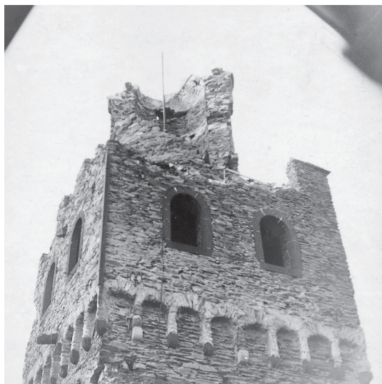
Abb. 2. Kriegsschäden am vierten Turmgeschoss und Butterfassaufsatz des Bergfrieds (aus: LAD Mainz, Fotoarchiv, Foto: M. Wendt, St. Goarshausen).
