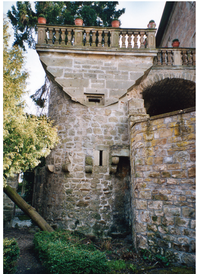
Abb. 10. Nördlicher Flankierungsturm, von Westen gesehen. Die beiden Wehrgeschosse dienen als Unterbau für die Altane des 18. Jahrhunderts. Die rudimentär erhaltenen Kragsteine trugen einen hölzernen Umgang über der Scharte des unteren Wehrgeschosses. Aus einer jetzt vermauerten Türe rechts konnte er vom Zwinger über das noch erhaltene Podest betreten werden und führte zum Wehrgang auf der links an den Turm anschließenden Stadtmauer (Foto: Verf.).
