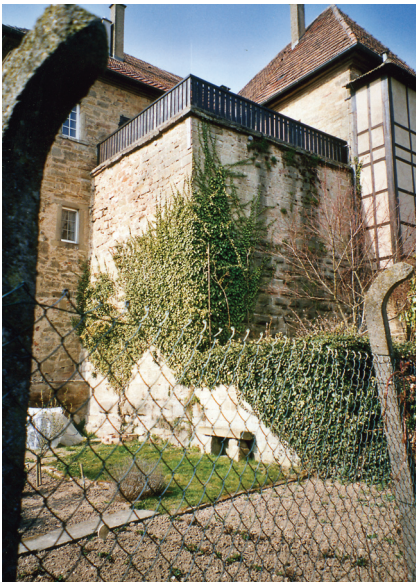
Abb. 3. Der Stumpf des hochmittelalterlichen Bergfrieds, als Unterbau für eine Altane, von der Südwestseite des Schlosses umfasst (Foto: Verf.).
