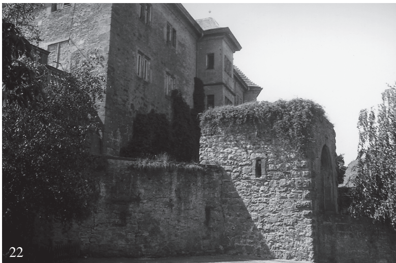
Abb. 22. Der Torbau 1971 (Foto: Verf.).
