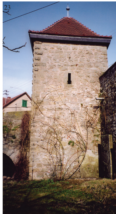
Abb. 23. Der Torbau 2003. Seit 1975 wieder unter Dach (Foto: Verf.).
