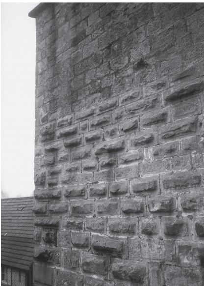
Abb. 4. Das Buckelquadermauerwerk des Bergfrieds. Darüber die Aufmauerung des späten 19. Jahrhunderts (Foto: Verf.).
