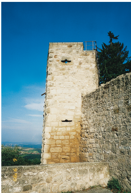
Abb. 10. Fünfeckiger Flankierungsturm an der südlichen Ringmauer (Foto: Verf.).
