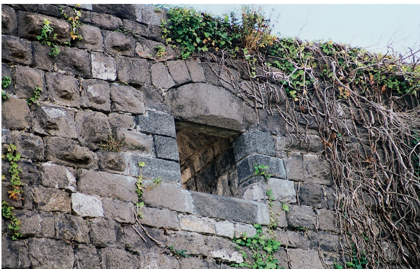
Abb. 9. Quillan. Rechteckiges Fenster mit monolithischem Entlastungsbogen in der nördlichen Ringmauer.
