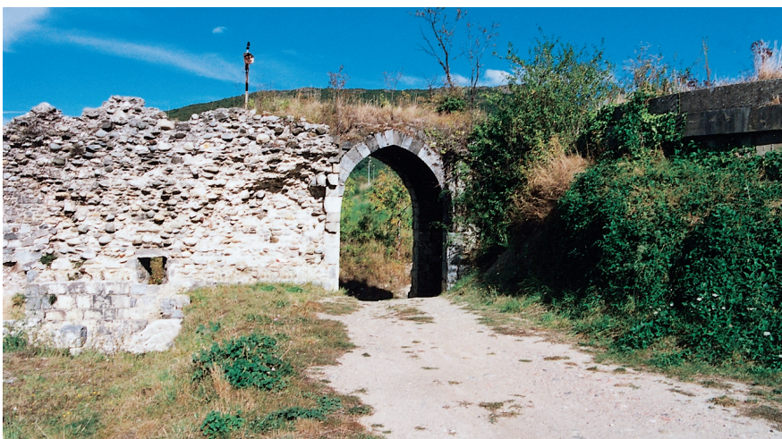
Abb. 6. Quillan. Die Hofseite des inneren Tores. Rechts erkennt man einen Teil des Wasserbehälters (12).
