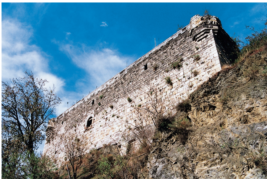
Abb. 7. Quillan. Buckelquader-Mauerwerk an der Westseite der Burg.
