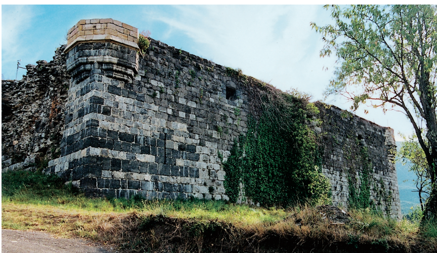
Abb. 8. Quillan. Die Nordseite der Burg.
