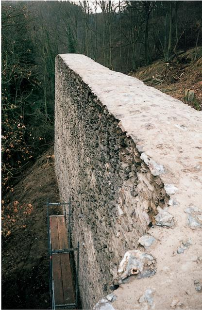
Abb. 10. Mauerkrone des Vorwerkes nach der Sanierung (Foto: Verf. 1996).
