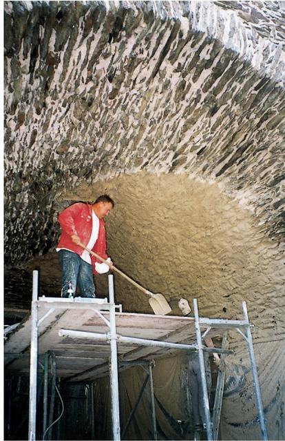
Abb. 11. Torkretieren des Torhausgewölbes (Foto: Verf., 2003).
