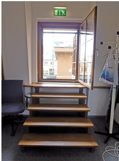
Abb. 22. Hinterleuchtete Rettungswegkennzeichnung (Foto: Verf.).
