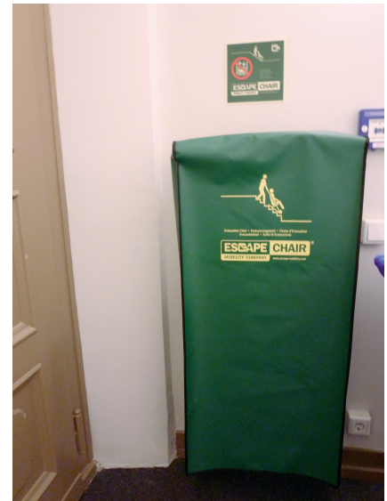
Abb. 24. Evakuierungsstühle sind in allen Büroflächen des Schlossgebäudes vorhanden.
