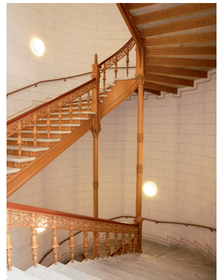
Abb. 3. Nichtbrennbare Konstruktionen in einem der Treppenhäuser (Foto: Verf.).
