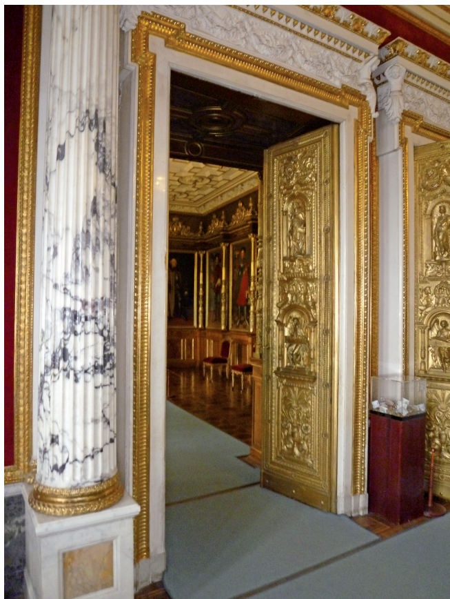
Abb. 25. Historische Holztür mit ausreichendem Feuerwiderstand (Foto: Verf.).
