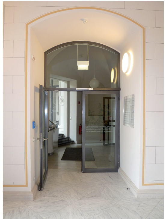
Abb. 18. Feuerschutzabschlüsse in historischer Brandmauer (Foto: Verf.).
