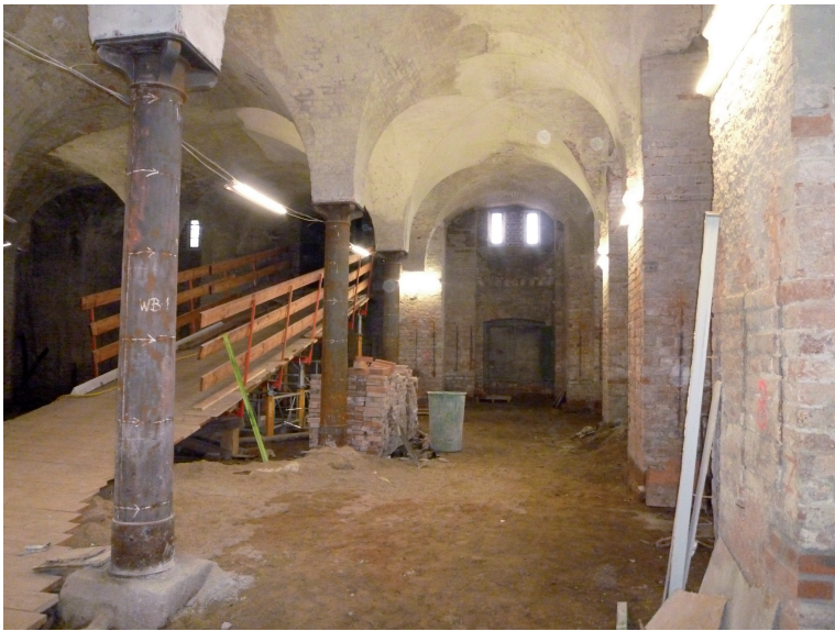
Abb. 17. Blick in einen Keller (Foto: Verf.).
