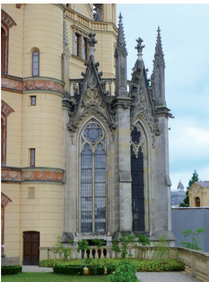
Abb. 2. Anbau des Chors am Schlossgebäude (Foto: Verf.).
