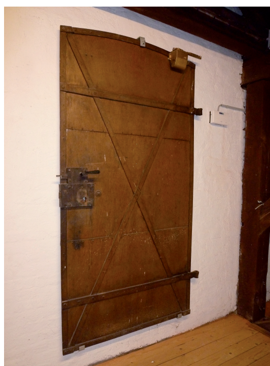
Abb. 16. Feuerschutztür des 19. Jahrhunderts (Foto: Verf.).
