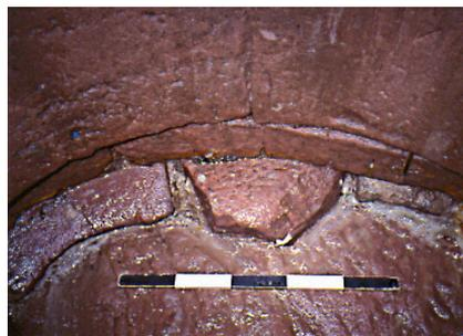
Abb. 22. Burg Helfenstein, Wand des Entnahmeschachtes der Filterzisterne (Foto: Uwe Welz).
