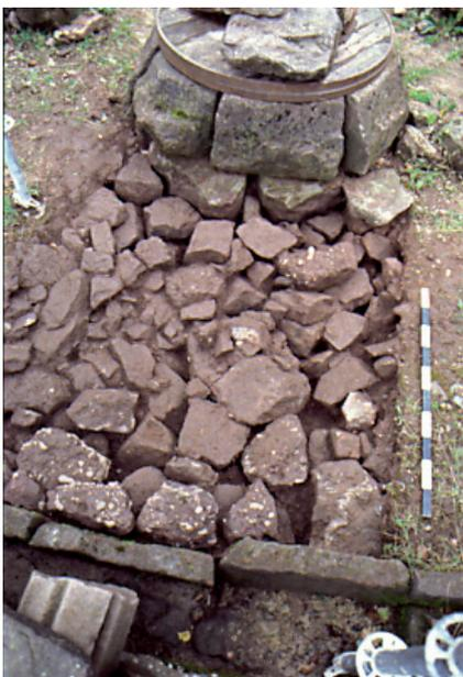
Abb. 13. Burg Wangenburg, Steine der Filterfüllung. Der Sand ist nach unten ausgespült worden (Foto: Verf.).
