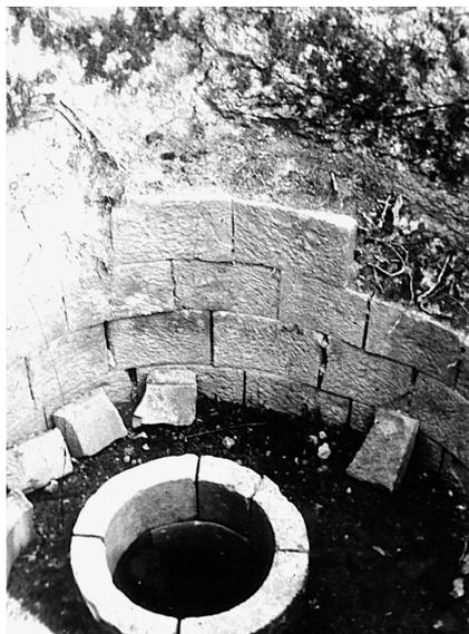
Abb. 21. Burg Wangenburg. Stabilisierung des Entnahmeschachtes durch unter den Bodensandsteinplatten gelegte Steine (Foto Verf.).
