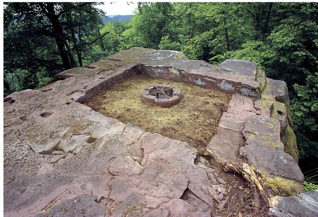
Abb. 5. Burg Helfenstein. Beispiel einer Filterzisterne, deren Filtergrube ganz im Sandstein ausgehauen ist (Foto: Uwe Welz).
