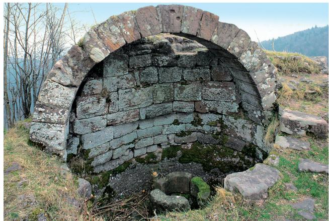
Abb. 8. Burg Groß Ochsenstein. Filterzisterne mit runder Filtergrube (Foto: Uwe Welz).
