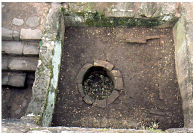
Abb. 12. Burg Alt-Wasigenstein. Filterzisterne mit Entnahmeschacht, der sich nicht genau in der Mitte der Filtergrube befindet (Foto: Verf.).
