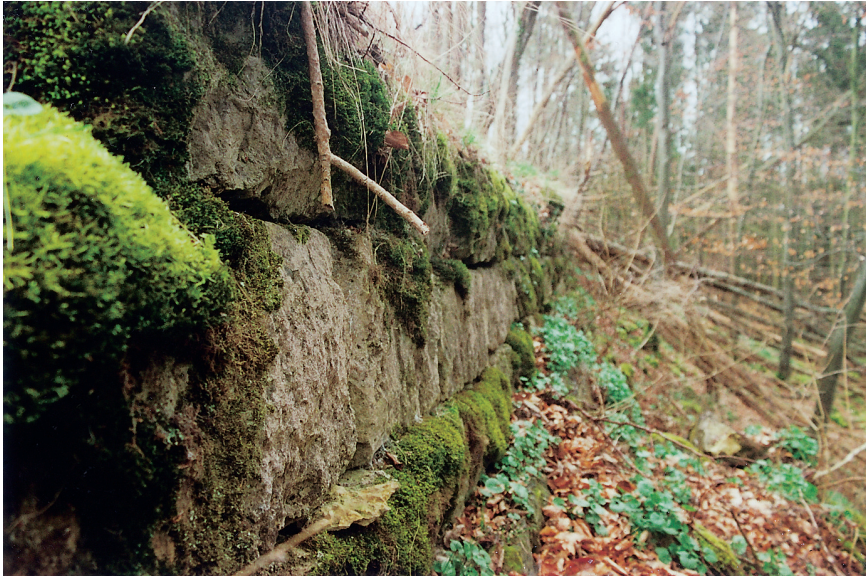
Abb. 1. Detail der östlichen Ringmauer (Foto: Verf.).
