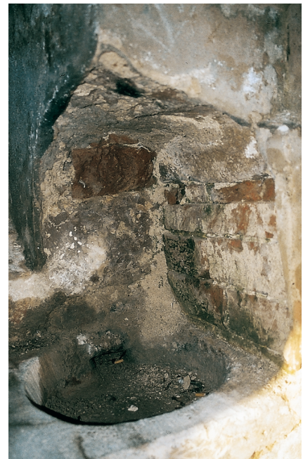
Abb. 10. Rezent aufmodelliertes rundes Ausgussbecken am Fenster. Der Ausguss ist noch original, ebenso die gemauerte Halbtonne über dem Boden (Foto: Regine Dendler, Jan. 2003).
