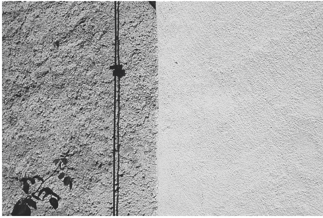
Abb. 5. Marksburg, Unterschiede in Struktur und Farbigkeit an den Putznähten zwischen Großer Batterie und Rheinseite (links) sowie zwischen Rheinseite und Kapellenturm (rechts) (Foto: Verf.).
