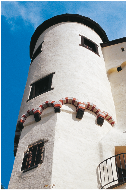
Abb. 6. Marksburg, Teilansicht des Pulverturms mit Bogenfries und rekonstruierter Farbfassung, 2002 (Foto: Verf.).
