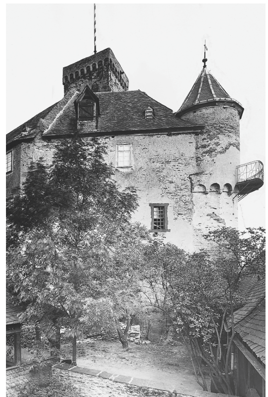
Abb. 9. Marksburg, Ansicht des Romanischen Palas und des Pulverturms, 1901 (DBV-Archiv, Fotosammlung Marksburg; Preußische Messbildanstalt 11K36/541.3).
