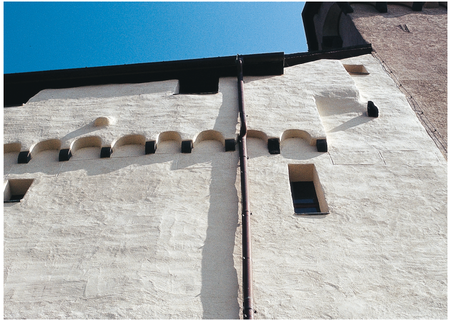
Abb. 7. Marksburg, Teilansicht der Rheinseite mit Kapellenturm, 2002. Die Schattenfuge gibt den Verlauf der romanischen Mauerkrone wieder (Foto: Verf.).
