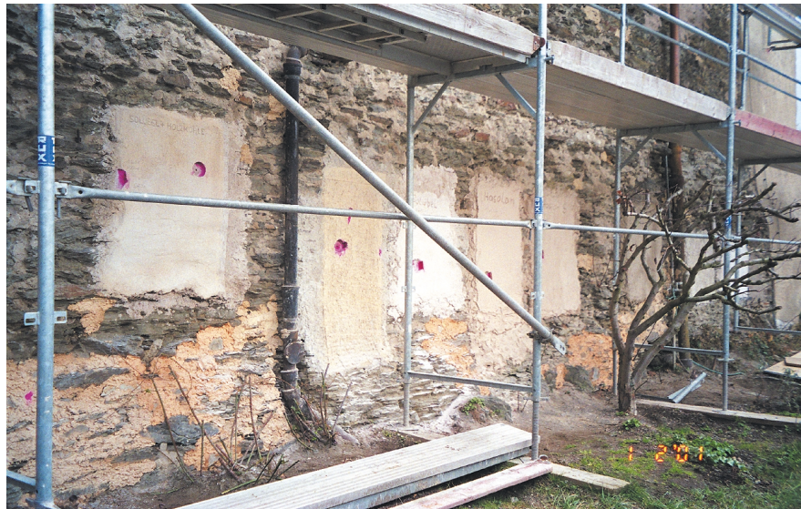
Abb. 8. Putzmuster am Rheinbau (Foto: Verf.; LAD Mainz).
