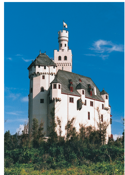
Abb. 2. Die „japanische“ Marksburg auf der Insel Ueno (Foto: DBV-Archiv, Dokumentation Marksburg/Japan).
