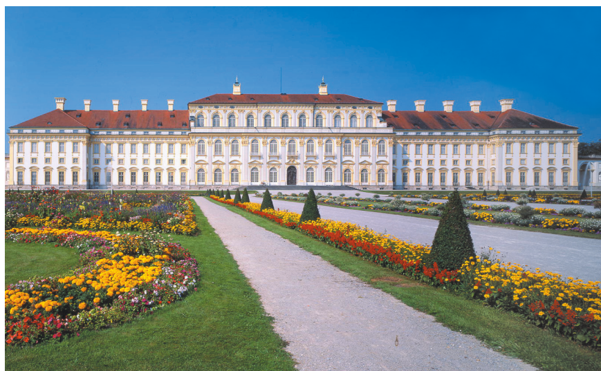
Abb. 1. Schloss Schleißheim, Gartenfassade (Foto: Staatl. Verwaltung der Bayerischen Schlösser, Gärten u. Seen).
