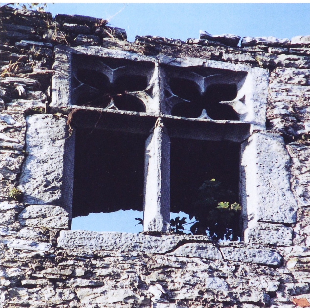
Abb. 9. Liebenstein. Kreuzförmiges Fenster mit Maßwerk (Foto: Verf.).
