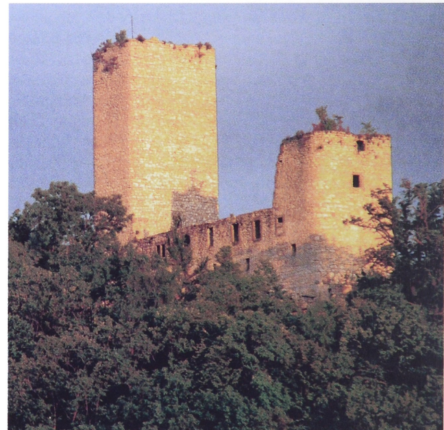
Abb. 10. Ehrenstein. Turm an der Ostseite und Erhöhung an der Westseite (Foto: Verf.).
