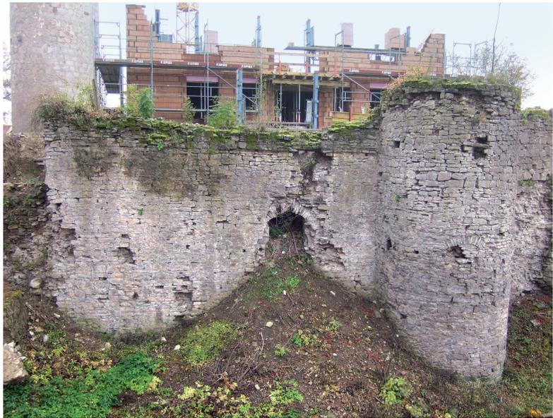
Abb. 9. Ansicht nach Süden auf die nördliche Zwingermauer mit Ausfallpforte aus der Zeit um 1400, mit dem angesetzten Flankierungsturm und Resten des Wehgangs aus der ersten Hälfte des 15. Jahrhunderts (Foto: Verf., 2009).
