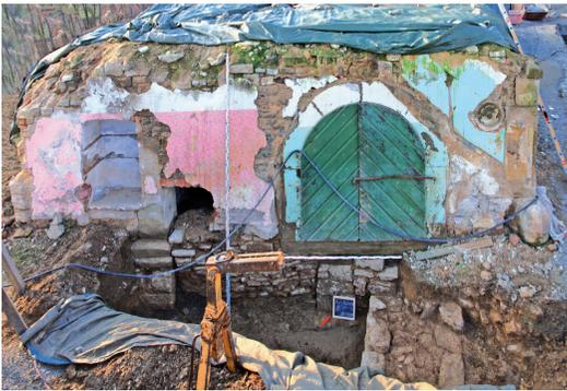
Abb. 8. Ansicht der Südwand des großen Gewölbekellers nach Norden. Der heutige Kellerabgang aus dem 16. Jahrhundert überlagert das auf Punktfundamenten stehende Zwingerportal des späten 13. Jahrhunderts (Foto: Verf., 2009).
