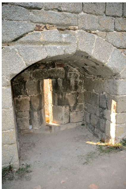
Abb. 14. Hoh-Andlau. Scharte 8 (Foto: Verf.).
