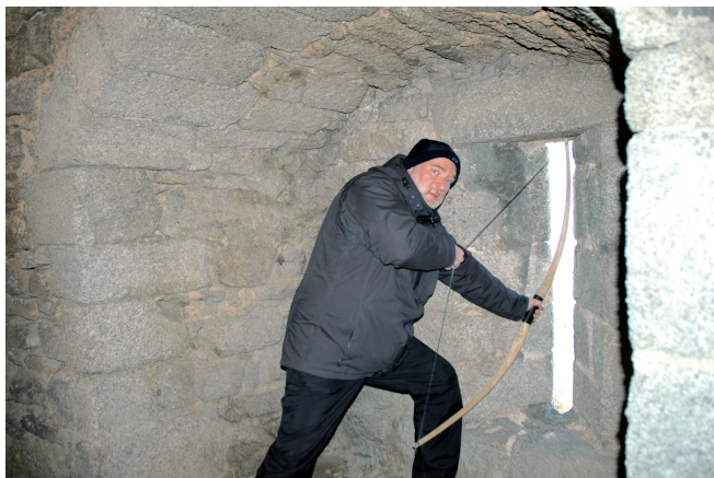
Abb. 8. Ortenberg. Schussversuch mit dem Langbogen aus Scharte 7. Bei der asymmetrischen Schießscharte 7 sieht man, wie der Bogen aus der Scharte geführt und genutzt werden kann (Foto: L. Bernges).
