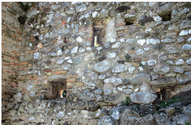
Abb. 7. Moniga del Garda, Südwestwand, nördlicher Teil, Innenansicht. Zu erkennen Reste der Putzschicht oberhalb der sekundären Schießscharten. Unten rechts im Bild der innere Teil des Entlastungsbogens, der außen deutlich ausgeprägter ist. Ebenfalls gut zu erkennen die zahlreichen Rüstlöcher, die sekundär auch als Balkenlöcher für einen Wehrgang unterhalb der Schießscharten genutzt wurden (Foto: Verf., 2010).
