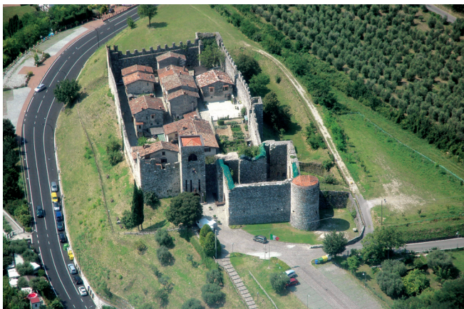
Abb. 9. Padenghe sul Garda, Luftansicht von Nordosten (Foto: Verf., 2010).
