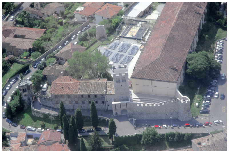
Abb. 30. Desenzano, Luftaufnahme von Norden (Foto: Verf., 2010).
