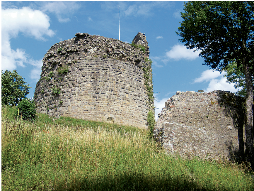
Abb. 11. Burg Botenlauben (Kreis Bad Kissingen). Südlicher Hauptturm.
