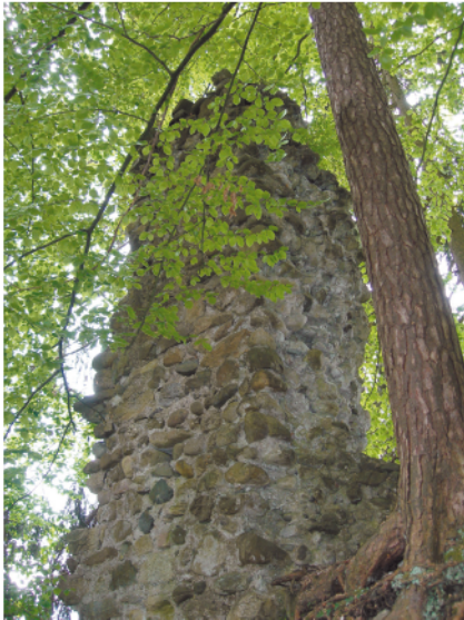
Abb. 3. Ringmauerrest der Burg Neu-Summerau (Foto: Verf., 2006).
