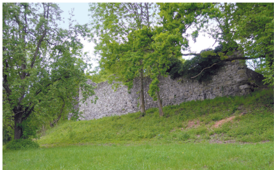
Abb. 6. Ringmauer der Burg Alt-Summerau, Feldseite (Foto: Verf., 2006).
