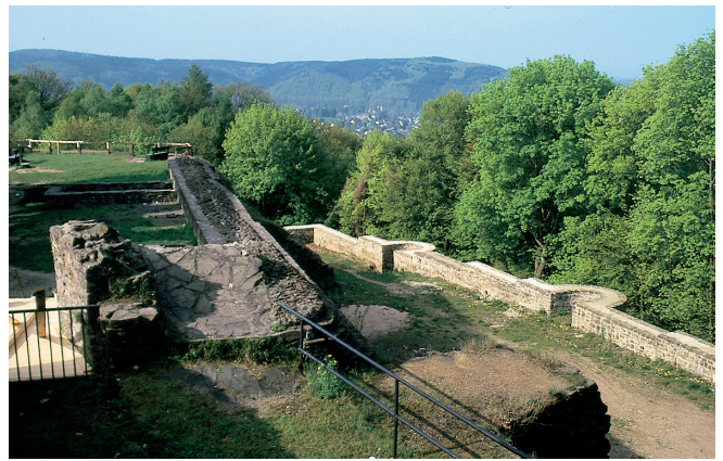
Abb. 13. Blick von Burghof auf die sanierte und wieder aufgeführte Zwingermauer (Foto: Verf., 2000).
