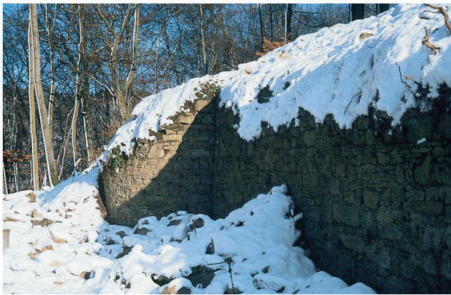
Abb. 12. Zwingermauer mit Schalentürmen (Foto: Verf., 1995).
