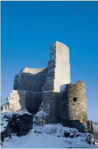
Abb. 9. Hofseitige Ansicht des Haupt- und des Treppenturmes (Foto: Verf., 1995).
