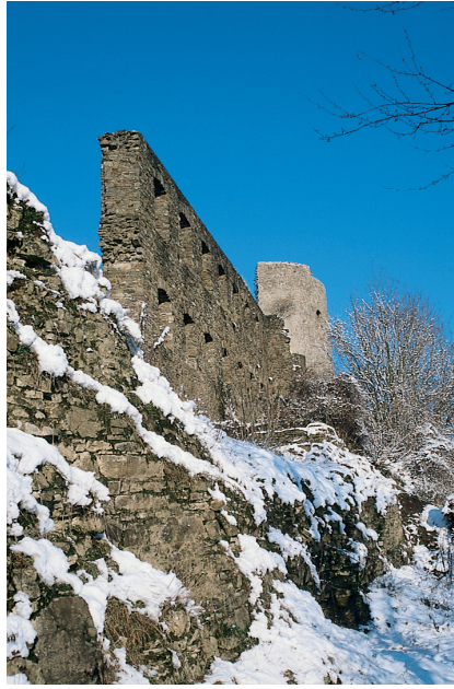
Abb. 10. Rekonstruierte „Palaswand“ (Foto: Verf., 1995).
