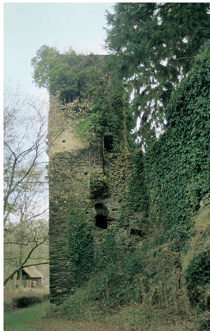
Abb. 8. Langenau. Viereckerturm an der nördlichen Ringmauer (Foto: Verf., 2004).
