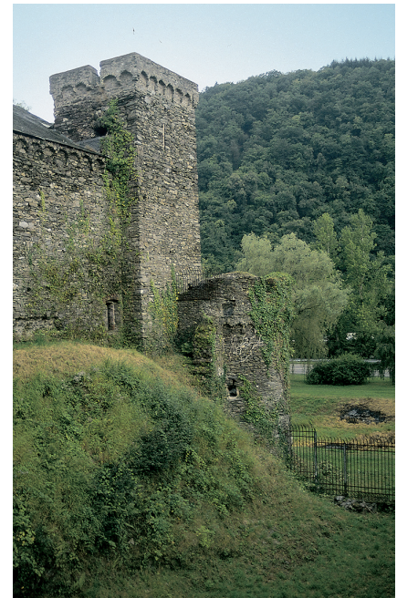
Abb. 9. Langenau. Südwestlicher Eckturm der Ringmauer und Rundturm der Zwingermauer (Foto: Verf., 2004).
