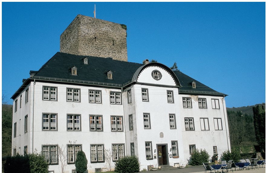
Abb. 11. Langenau. Barockes Herrenhaus (Foto: Verf., 2004).
