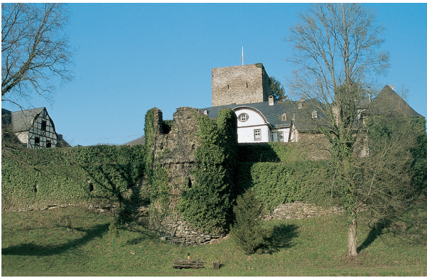
Abb. 4. Langenau. Südliche Ringmauer mit Zwingeranlage und mittlerem Flankenturm (Foto: Verf., 2004).
