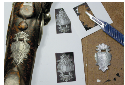
Abb. 1. Arbeitssituation an dem Kurzgewehr IV.E.257 (vielleicht Niederlande, um 1700). Gezeigt wird in der Mitte ein Computerausdruck für eine sog. Fotoergänzung, rechts das Zuschneiden, links die bereits in das Original eingepasste Ergänzung (Kunstsammlungen der Veste Coburg).
