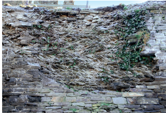
Burgruine Are, Altenahr (Lkr. Ahrweiler). Ährenegefüge im Kernmau- erwerk der Ringmauer (Foto: A. Schmidt).
