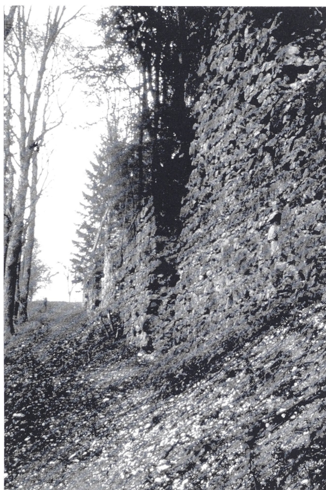
Abb. 2. Blick entlang der Westseite des Inneren Schlosses (Foto: S. Uhl).
