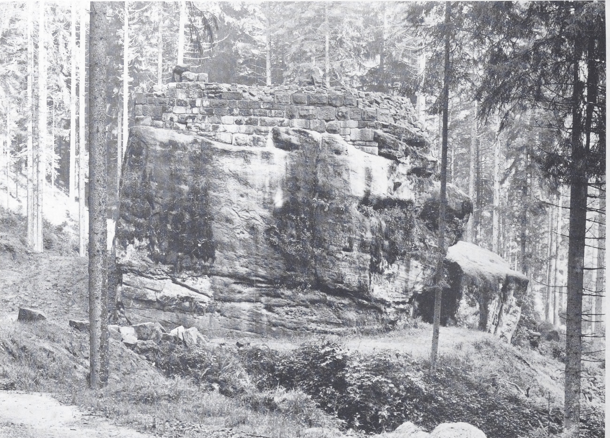
Abb. 10–11. Ruine Tannenfels bei Baiersbronn, Kr. Freudenstadt, vor und nach Sicherungsarbeiten, wobei es vor allem darauf ankam, die Umfassungsmauern des Turmes, die abzustürzen drohten, in ihrem Bestand zu sichern und das ursprünglich wuchtige Erscheinungsbild der kleinen Anlage wieder erlebbar zu machen (Foto: Landesdenkmalamt Baden-Württemberg, Karlsruhe).
