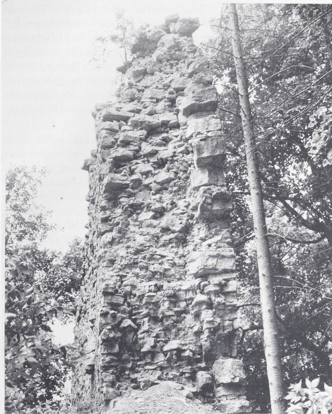
Abb. 2. In Auflösung begriffene Schildmauer der Ruine Frundeck bei Horb-Abldorf, Kr. Freudenstadt. Die Aufnahme zeigt deutlich die großen Steine vor allem der feldseitigen Mauerschale, sowie das Füllmauerwerk aus unbearbeiteten Steinen und viel Mörtel (Foto: Landesdenkmalamt Baden-Württemberg, Karlsruhe, 81 A 93).
