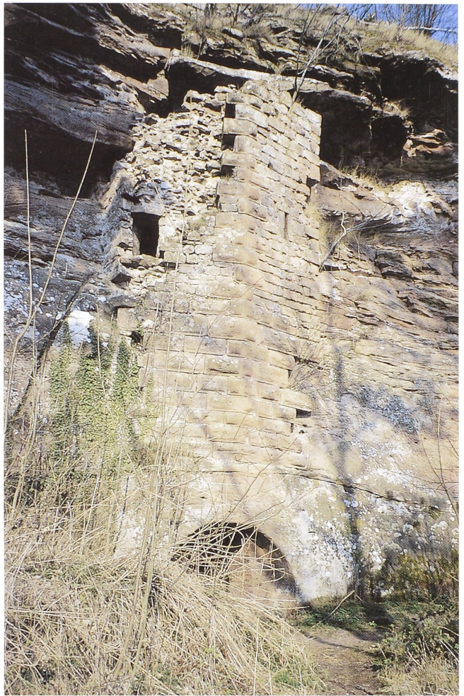
Abb. 8. Brunnenschacht von Westen: bereits löchriges Erkennungsmerkmal einer ehemaligen Lebensnotwendigkeit (Foto: H. Hofrichter, 21. 2. 1990).
