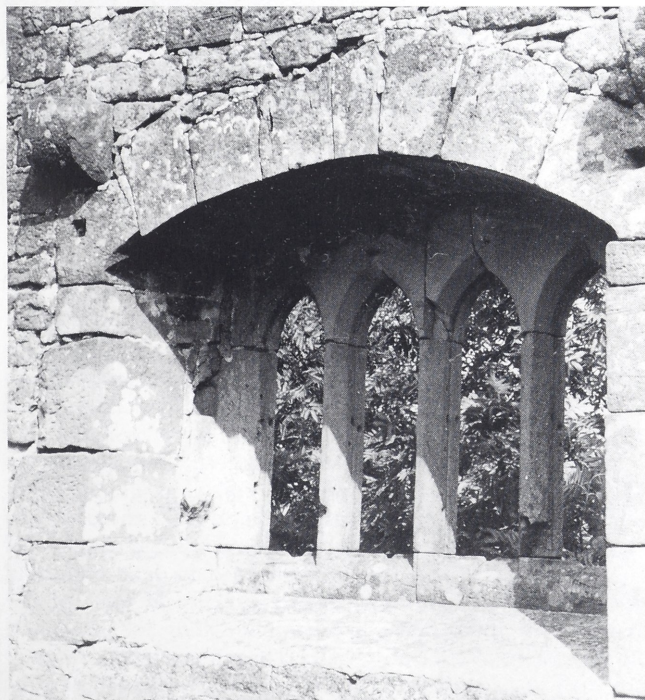
Abb. 9. Oberburg. Südpalas. Vierteliges Fenster (2. H. 13. Jb.?): Zustand 1962 (Foto: P. Pohlit).
