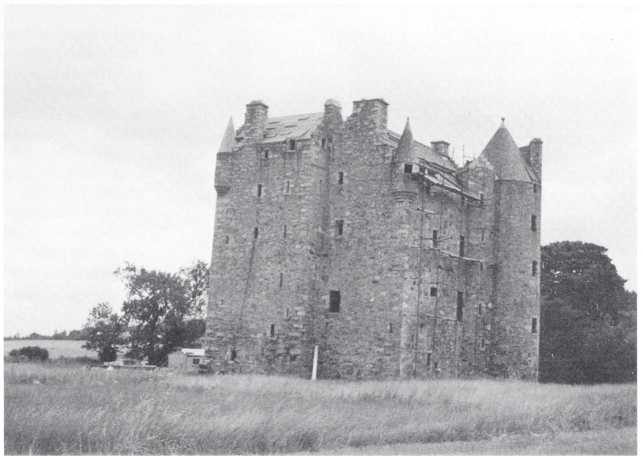
Abb. 10. Harthill Castle, Aberdeenshire (Typ Z 2). Um 1560/70. Ansicht von Nordwesten. Zustand vor Neuverputz, während der Renovierungsarbeiten (Foto: Gerhard Graf, München, im Sommer 1975).
