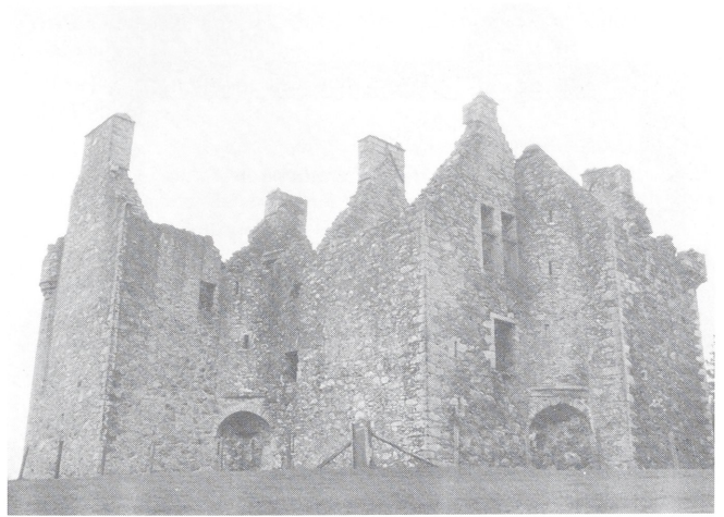
Abb. 12. Glenbuchat Castle, Aberdeenshire (Typ Z 3). 1590 baudatiert. Blick auf die Gebäuderückseite von Nordwesten. Interessant ist die Auskrägung der Treppentürmchen durch Flugbögen, sog. „Trompes“ (Foto: Verfasser vom 20. 5. 1983).
