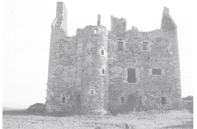
Abb. 13. Fenton Tower, East Lothian (Typ L/Z). 1577 baudatiert. Blick von Norden auf die Gebäuderückseite mit Halbrundturm und Treppenkern (Foto: Verfasser vom 19. 6. 1983).
