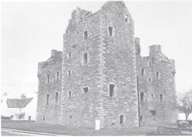
Abb. 5. MacLellan's Castle, Kirkcudbrightshire (Type L 4). 1582 baulatiert. Ansicht von Süden. Blick auf den rückseitigen Vier-eckflügel, mit den rechteckigen Geschützcharten im Turmfuß (Foto: Verfasser vom 18. 4. 1983).
