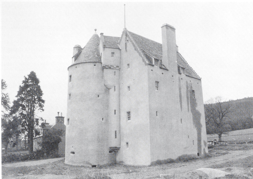
Abb. 3. Pitfichie Castle, Aberdeenshire (Typ L 2). Um 1560/70. Ansicht von Osten. Bemerkenswert ist die erneute Verlagerung der Treppe über dem 2. Stock in ein winziges Erkertürmchen. Der gekrümmte Schornstein des Rundturms findet sich auch am etwa gleichzeitig errichteten Harthill Castle (siehe Abb. 10; Foto: Verfasser vom 20. 5. 1983).
