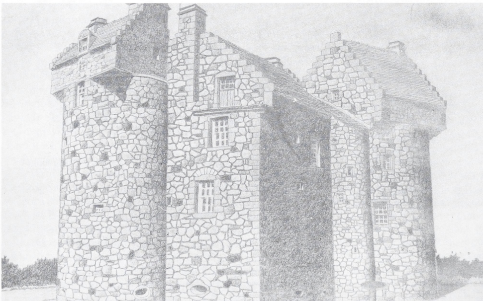
Abb. 6. Claypotts Castle, Angus (Typ Z 1). 1569 und 1588 baulatiert. Ansicht von Südosten. Beachtenswert sind die vielen Maultscharten im Gebäudefuß, von denen jene im rechten Rundturm das danebenliegende Treppentürmchen durchschneidet, sowie die Auskragung der Turmoberteile zu weit ausladenden Kappenhäusern. Fotografie nach einer Bleistiftzeichnung des Verfassers 1980.
