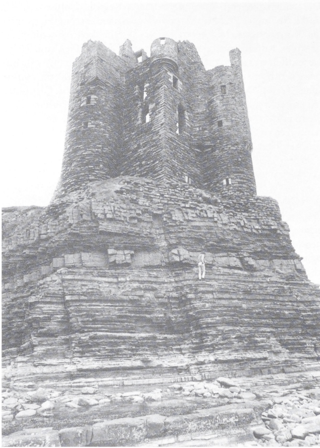
Abb. 8. Keiss Castle, Caithness (Typ Z 1). Um 1560/70. Blick von Süden auf die dem Meer zugewandte, fast intakte Rückseite des schlanken Wohnturms. Die Konsolgesimse der Pfefferbüchse und das Dachfenster tragen Reste eines Würzelfrieses (Foto: Verfasser vom 25. 7. 1984).
