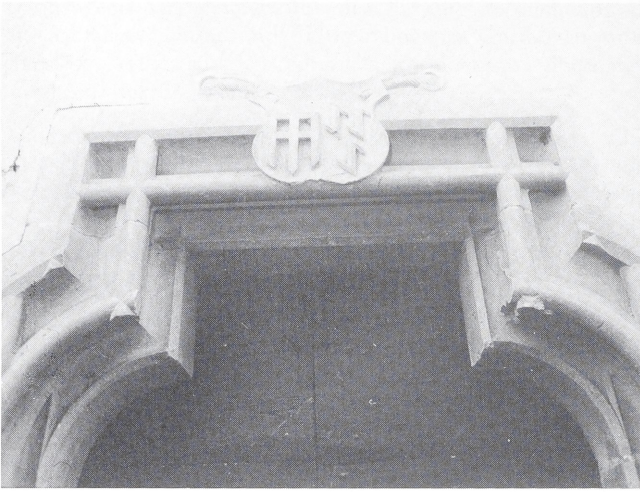
Abb. 3. Schelenburg, Portal zum Turmbau (Foto: WRM – Verfasser 1987).
