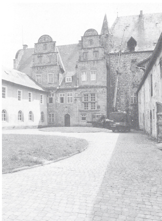
Abb. 8. Schelenburg, Hoffassade (Foto: WRM – Verfasser 1987).
