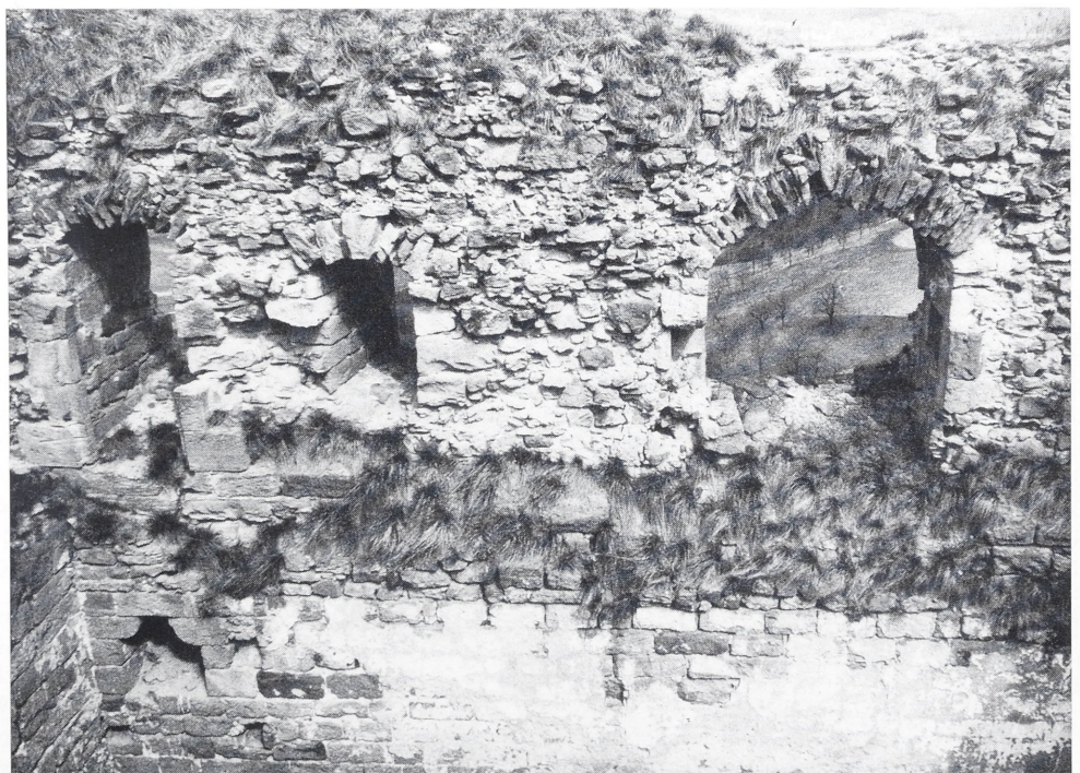
Abb. 11. NW-Ecke innen/oben. Zustand 1973. (Foto: Preiser).
