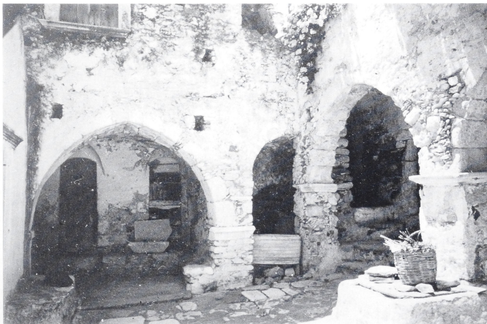
Abb. 9. Südwestseite des Hofes mit Westwand der Kirche (links), dahinter Ende des Eingangstunnels und halbe Hofarkade, hinter der Reste des Altbaues sichtbar sind. Rechts Antritt der Treppe in der Südwestecke. Im Vordergrund unter dem Korb die Einfassung der Zisterne. (Foto: Verfasser).
