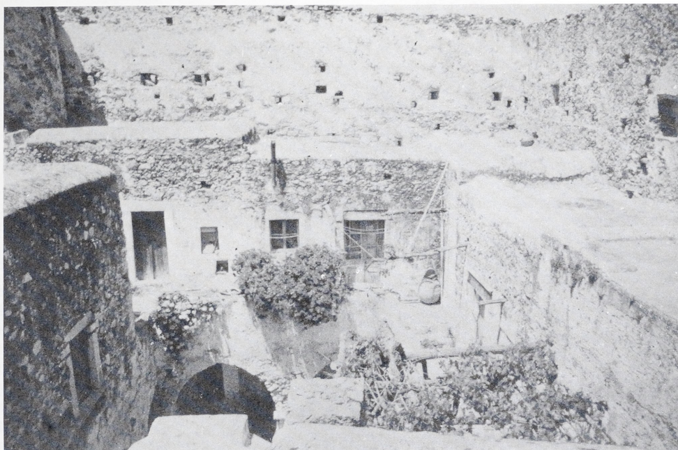
Abb. 10. Dachgeschoß gegen Nordwesten mit Schießcharten und Balkenlöchern. Links ein Teil des Rundturmes. (Foto: Verfasser).
