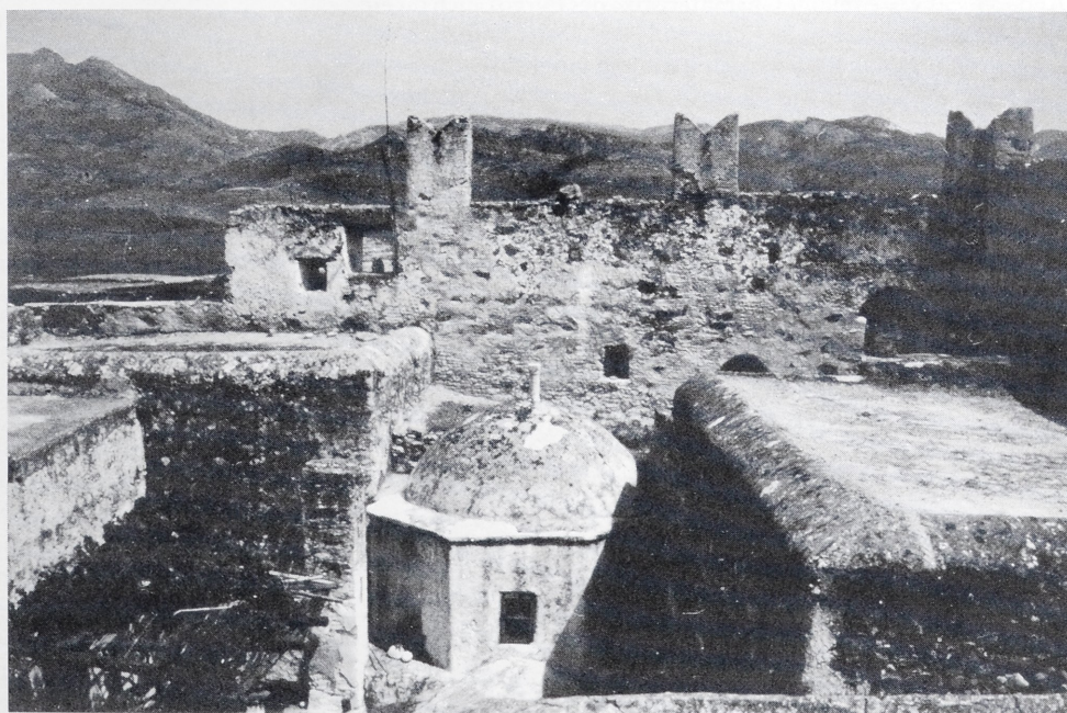
Abb. 11. Südostwand von Innen mit der Kuppel der Kirche. Rechts das Dach der Sala. Die rundbogigen Öffnungen hinter der Sala sind für den Gußerker (links) und ein vermutliches späteres Fenster (rechts). (Foto: Verfasser).
