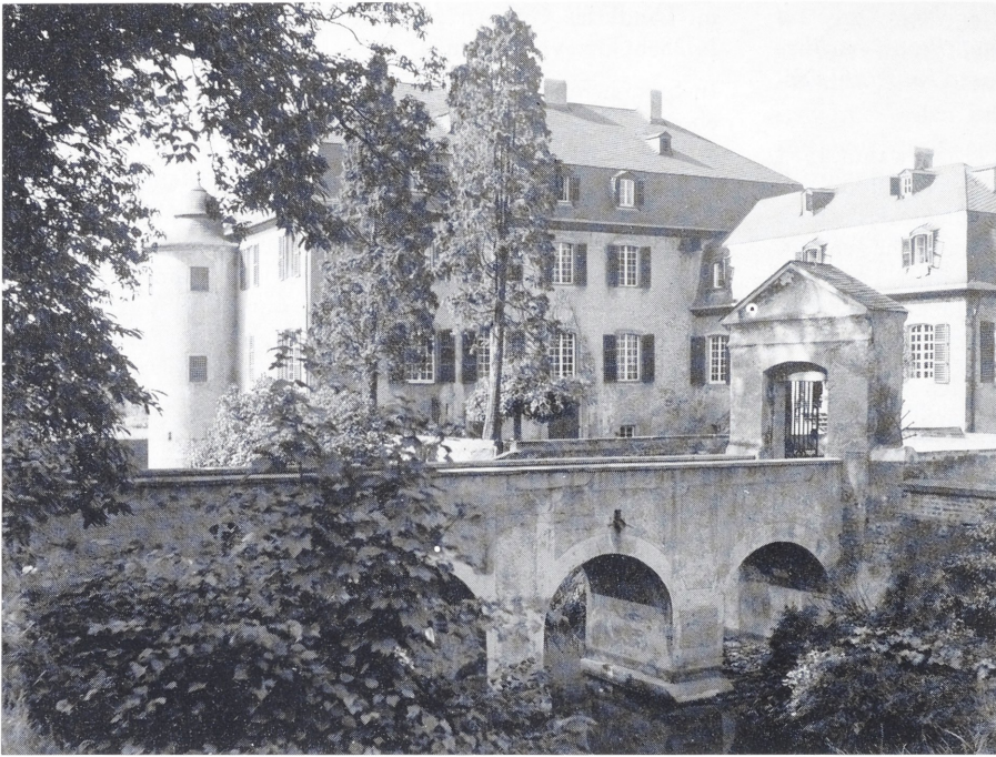
Abb. 3. Burg Lüftelberg in Meckenheim, Rhein-Sieg-Kreis. (Foto: DBV-Archiv).
