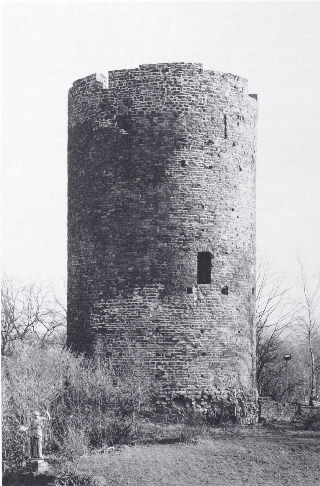
Abb. 4. Fotografie des Bergfrieds mit Blick von Südwest.
