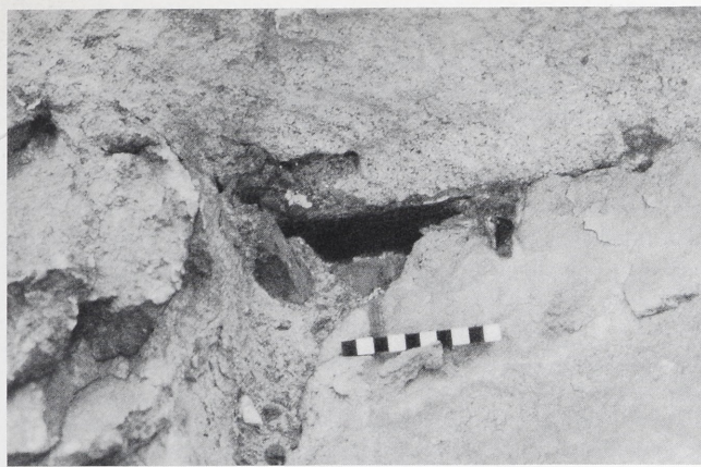
Abb. 9. Bergfried, Eisenklammer; oben Wolfsloch (Köhl 1991).
