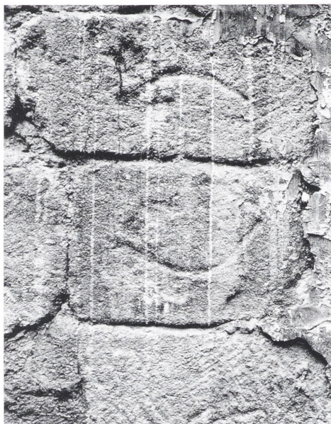
Abb. 2. Salemer Pfleghof, südliche Innenwand (Foto: Verf.).
