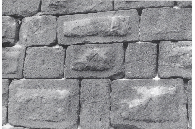
Abb. 13. Burg, westliche Schenkelmauer (Foto: Verf.)
