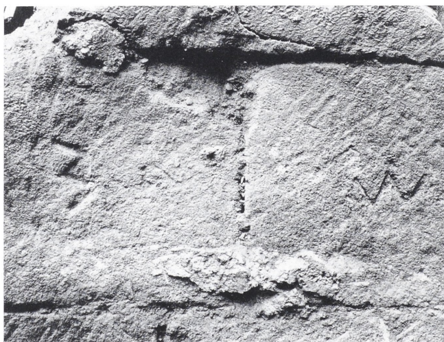
Abb. 3. Salemer Pfleghof, südliche Innenwand (Foto: Verf.).
