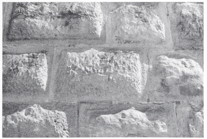
Abb. 12. Pliensauturm, Westwand (Foto: Verf.)
