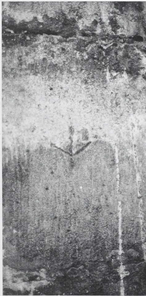
Abb. 11. Innere Brücke, Untersicht Bogen IV (Foto: Verf.)
