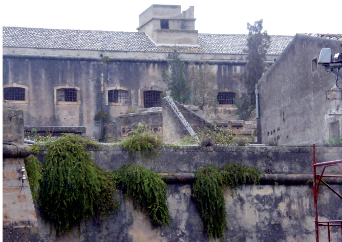
Abb. 3. Blick von außen (Süden) auf den Frontmauerturm, von dem die drei obersten Buckelquader-Reihen mit Mühe zu erkennen sind (Foto: Verf.).
