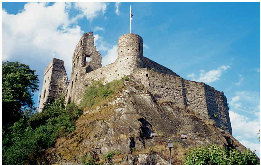
Abb. 2. Kastellaun (Rhein-Hunsrück-Kreis), Burg. Gesamtansicht aus südwestlicher Richtung.
