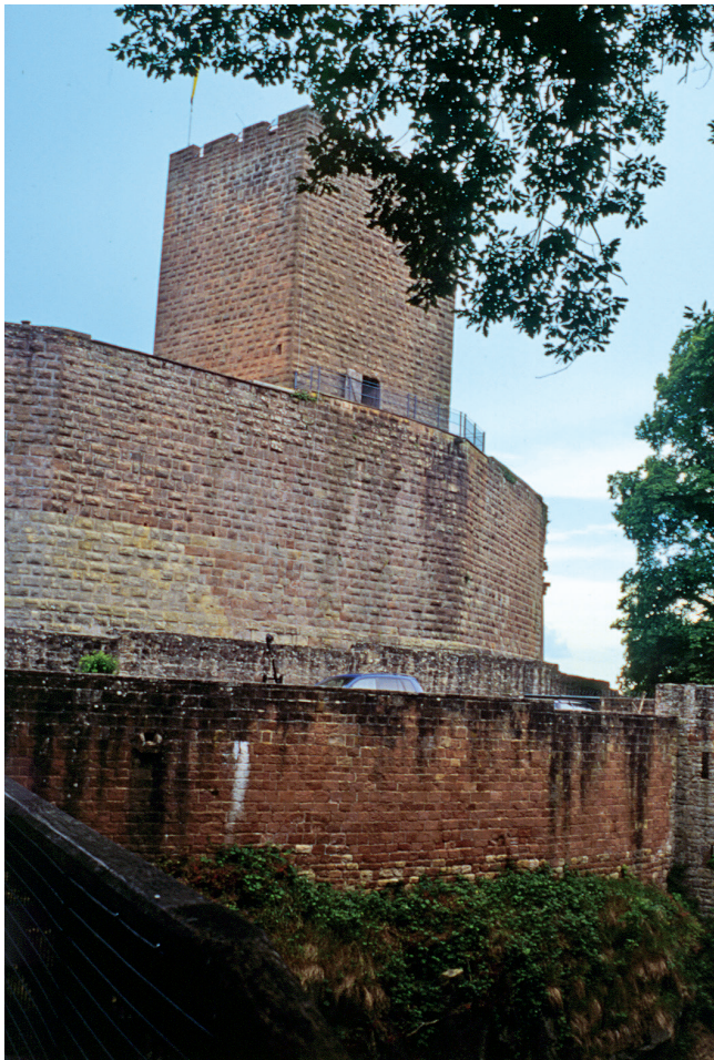
Abb. 4. Klingmünster (Kreis Südliche Weinstraße), Burg Landeck. Blick von der 1967 rekonstruierten Zugangsbrücke auf Bergfried, Mantelmauer, Zwinger und „Vorwerk“.
