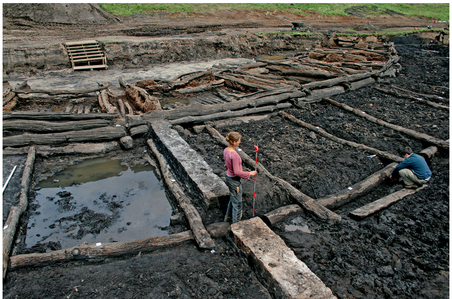
Abb. 11. Heidenwall. Blick von der Außenseite auf die Holz-Erde-Befestigung (Foto: Verf.).
