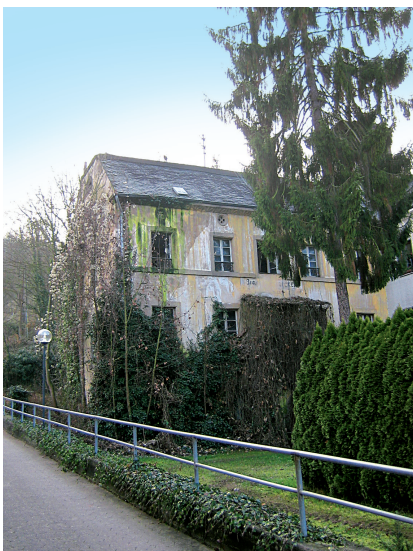
Abb. 1. Weckbeckerschlosschen, Kernbau (Foto: Verf., 2009).
