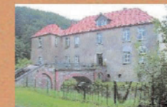
Wasserburg mit Nebengebäuden, Extrem verkehrsgünstig gelegenes Kulturgut, direkt an der Autobahn bei Düsseldorf für 850.000,- Euro
