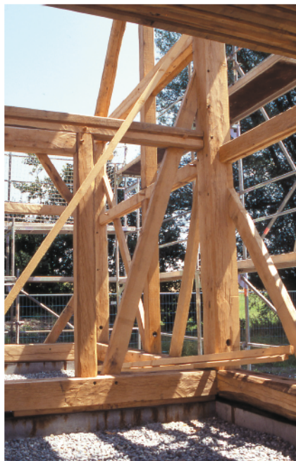
Abb. 5. Bauernhaus, Blick auf Teile der Fachwerkkonstruktion während des Aufrichtvorganges. Über dem Betonfundament als moderner statischer Notwendigkeit wurde die Fachwerkkonstruktion getreu mittelalterlichen Vorbildern aufgestellt (Foto: Verf.).
