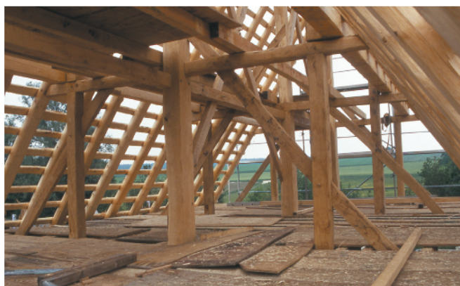
Abb. 12. Scheune, Blick durch das Dachwerk während des Aufrichtvorganges. Die komplexe Gestaltung der Dachkonstruktion widerlegt jedes Vorurteil vom vermeintlich primitiven mittelalterlichen Bauwesen (Foto: Verf.)
