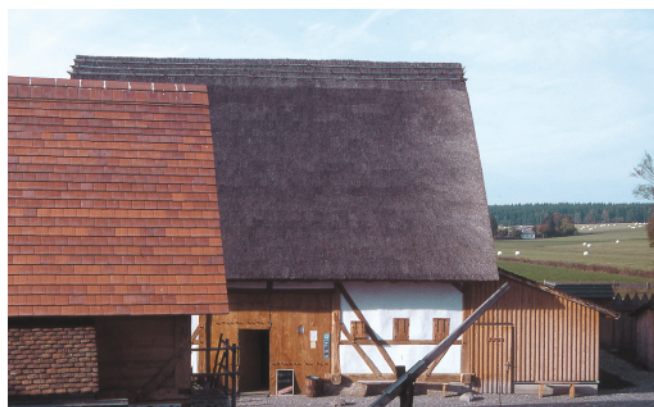
Abb. 13. Blick vom Wohnturm auf die fertiggestellte Scheune mit ihrem mächtigen Strohdach. Rechts der moderne Toilettenbau und im Vordergrund der ebenfalls schon fertiggestellte Speicher mit seiner Ziegeldeckung (Foto: Verf.)
