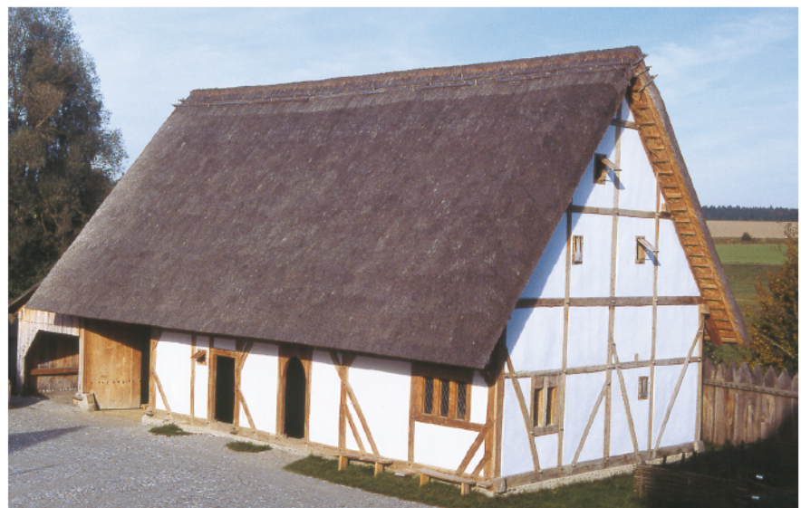
Abb. 9. Blick auf das Bauernhaus nach der Fertigstellung. Die Gefache sind mit Lehmflechtwerk geschlossen und gekalkt, das Dach ist mit einer Schilfdeckung versehen (Foto: Verf.).
