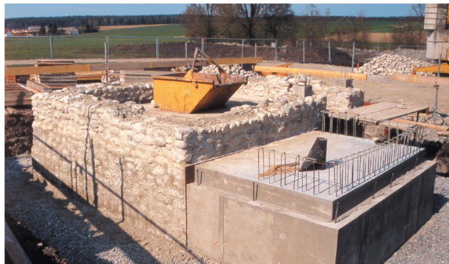
Abb. 15. Speicher, Blick auf den Mauersockel während der Bauphase. Im Vordergrund das Betonfundament des „modernen“ Kassenhäuschens (Foto: Verf.).
