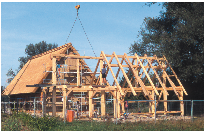
Abb. 19. Wirtschaftsgebäude, Ansicht von Süden während des Aufrichtvorganges der Fachwerkkonstruktion (Foto: Verf.).
