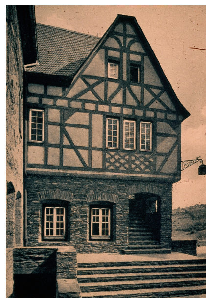
Abb. 12. Burg Stahleck. Küchenanbau am Palas, vor der Restaurierung 1990 (DBV-Archiv, Nachlass Stahl).
