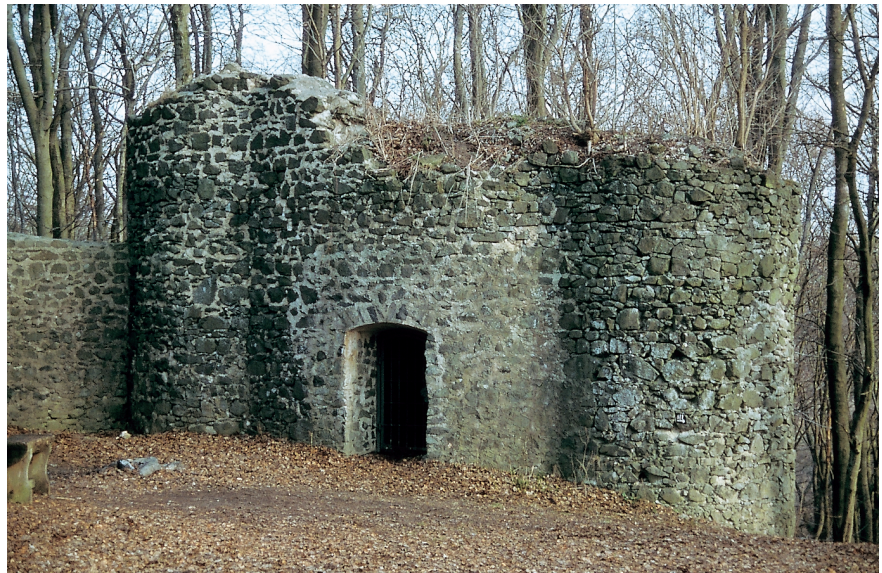
Abb. 6. Burg Eigenberg. Hofseitige Ansicht des Hauptturmes (Foto: Verf., 1999).
