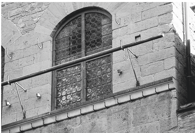
Abb. 11. Florenz, Palazzo Davanzati, zweites Obergeschoss, Rekonstruktion der erri und Querstangen (Foto: Verf.).
