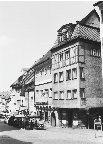
Abb. 2. Ravensburg, Humpisquartier. Blick entlang der Marktstraße mit den Gebäuden Marktstraße 49, 47 und 45 (von rechts nach links).
