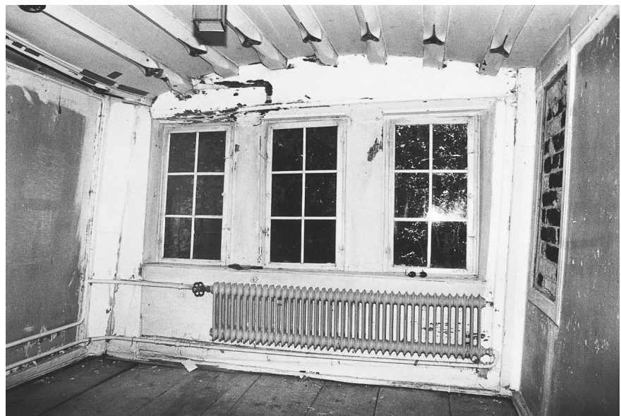
Abb. 9. Ravensburg, Humpisquartier. Dachraum des Gebäudes Marktstraße 45 mit spätmittelalterlichen Spundwänden (um 1435 d).
