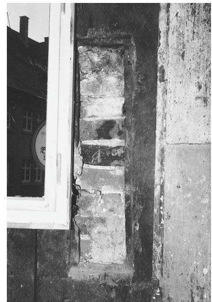
Abb. 13. Ravensburg, Humpisquartier. Fenster von 1375 in der Bohlenstube des Gebäudes Marktstraße 49.
