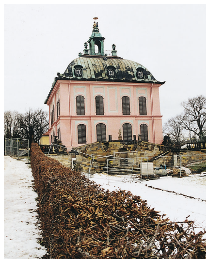
Abb. 1. Fasanenschlösschen, Landkreis Meißen. Restaurierung der Freitreppe. Abgeschlossen ist bereits die Wiederherstellung der ursprünglichen Außenfarbigkeit (Foto: Verf.).
