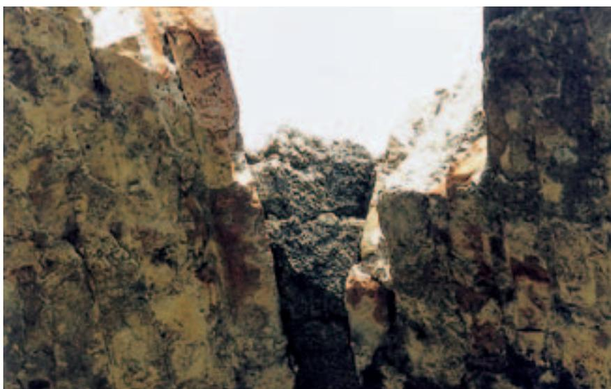
Abb. 3. Fiorentino, „Pyramidenturm“. Ausbildung des „Kreuzes“ im Gewölbe mit keilförmigem Naturstein zwischen den Gewölbekappen aus Ziegeln (Foto: Verf., ca. 1970).
